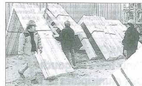
ÉTAPE 2. Chaque partie (charpente, murs...) est réalisée sur les chaînes de l'usine qui fonctionnent jour et nuit.
